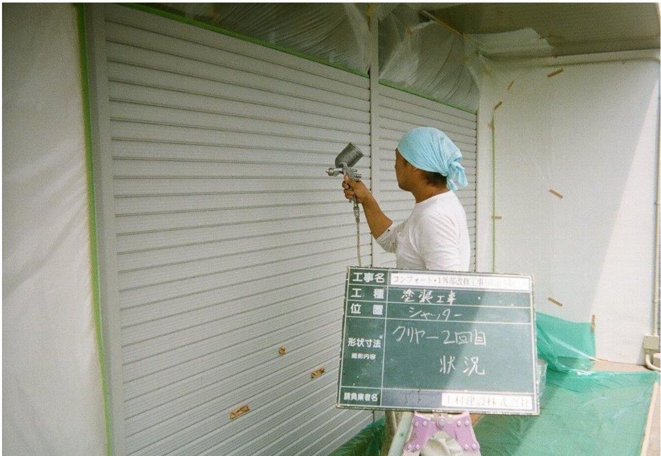
ナノコンスーパ-2400 塗装風景(2回塗りの2回目)
